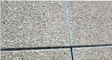
PCB-haltige Fugendichtungsmasse
