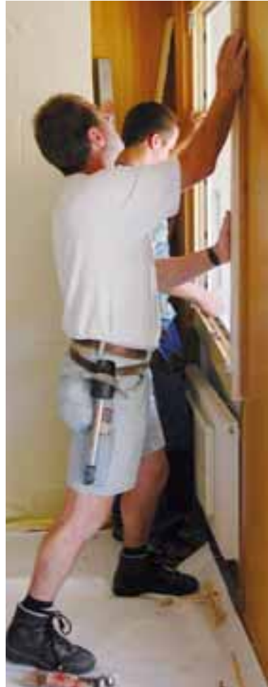
Massarbeit bei der Fenstermontage.
