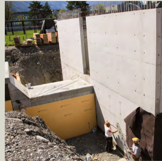
Absolut makelloser Sichtbeton war eine der Anforderungen.
